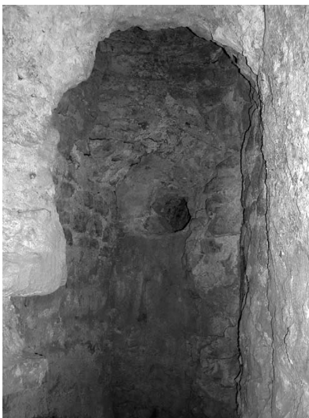
4. Chiusura in muratura dello speco, intonacata in cocciopesto (foto Placidi).
